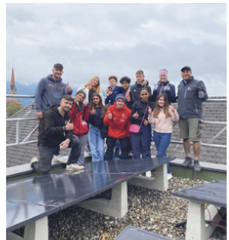
Freuen sich über ihr gelungenes Projekt: Lernende der Oberschule Vaduz haben auf dem Dach des HPZ eine Photovoltaikanlage installiert.
