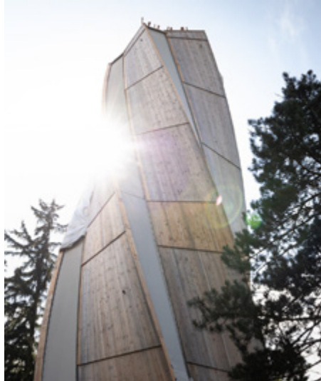
Der Turm auf Dux wird am 16. August eröffnet.
